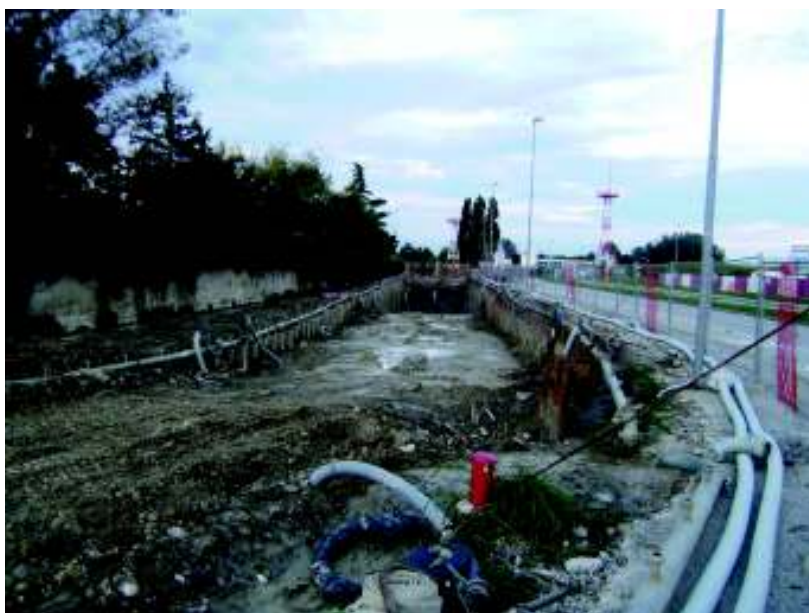
Figura 4. Immagine fotografica dei lavori di realizzazione del nuovo tratto tombinato dello scolo Pagliagheta.
