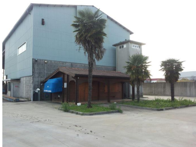
FOTO 3: Vista dei locali uffici e servizi.
