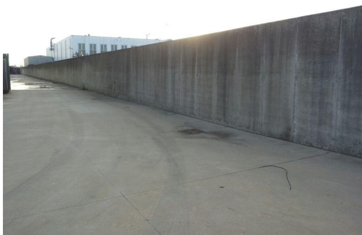
FOTO 4: Vista del confine sul lato est. capannone
