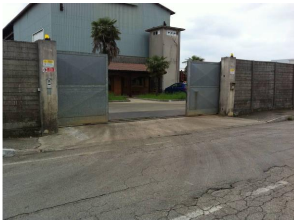
FOTO 1: Vista dell'accesso all'impianto.
