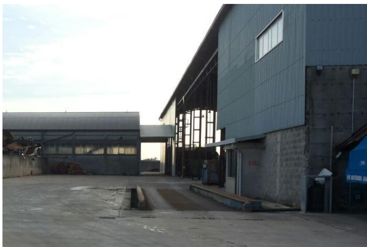
FOTO 2: Vista della pesa a fossa e dei piazzali esterni.
