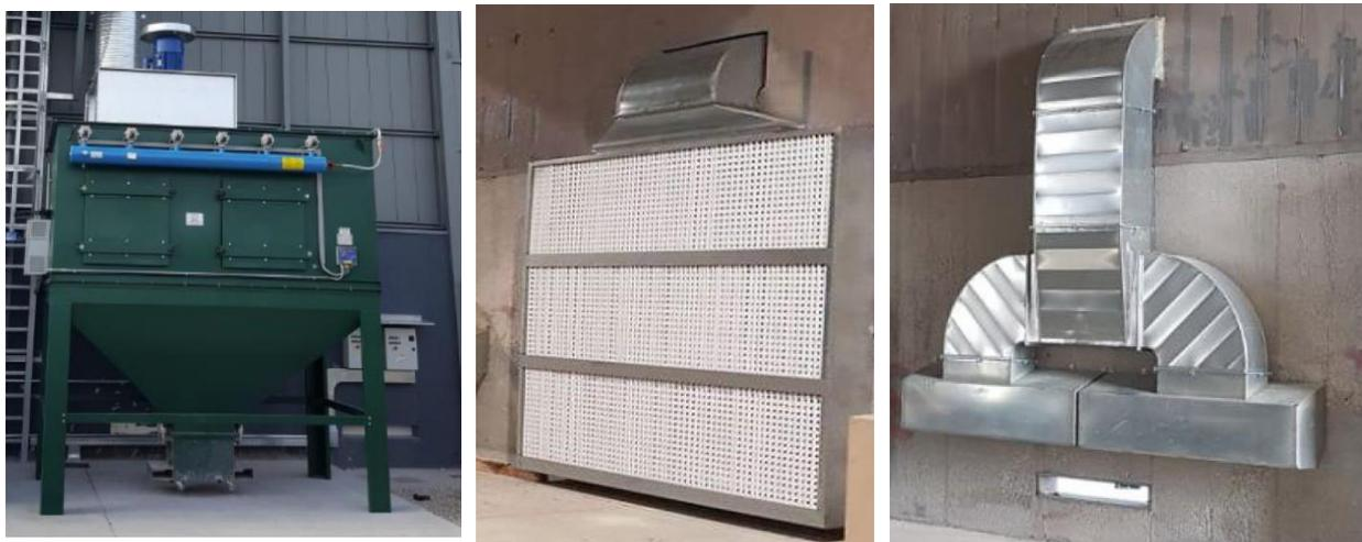
Figura 10 – Sistemi mobili di aspirazione previsti a servizio delle coperture mobili esistenti
