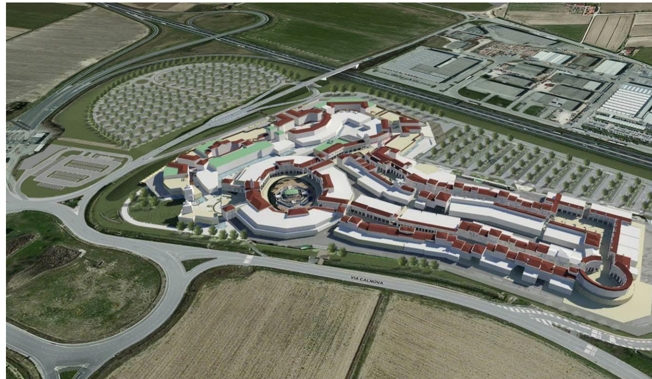
Vista complessiva dell'area a intervento realizzato da sud-est.
