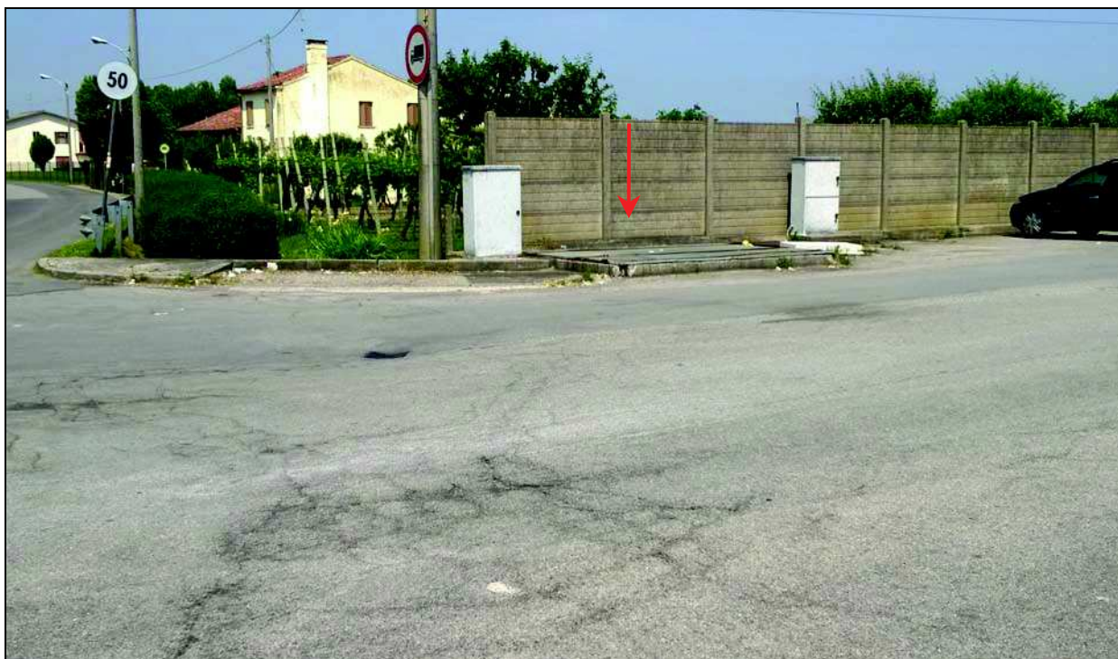
Foto 12 – Accesso del parcheggio su via Bastie: vasca di sedimentazione della rete drenante esistente
