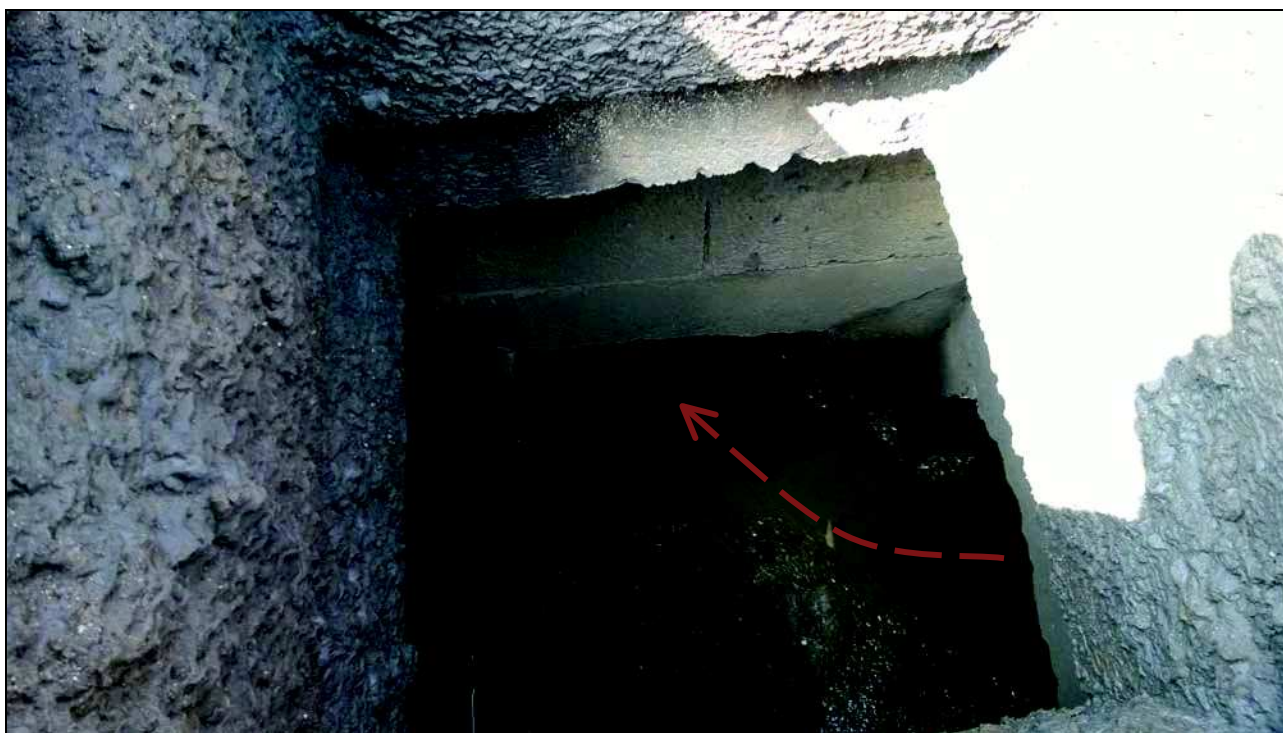
Foto 27 – Vista interna dal chiusino 0, posto sull'incrocio fra via Bastiette e la da S.S. Romea: si notano depositi di una fognatura di tipo misto; la direzione di deflusso indica lo scarico nella condotta di drenaggio della foto precedente.
