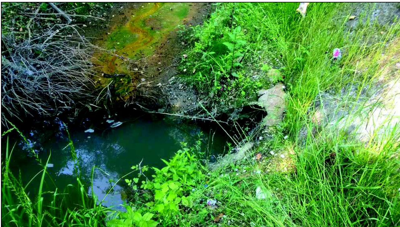
Foto 18 – Punto di scarico del tombino di attraversamento dell'area commerciale: si osservano i depositi vegetali in alto sulla sinistra
