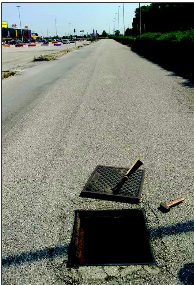
Foto 21, 22 – Strada interna di accesso all'area commerciale: posizionamento dei chiusini di ispezione sul tombino di drenaggio di un precedente canale di scolo
