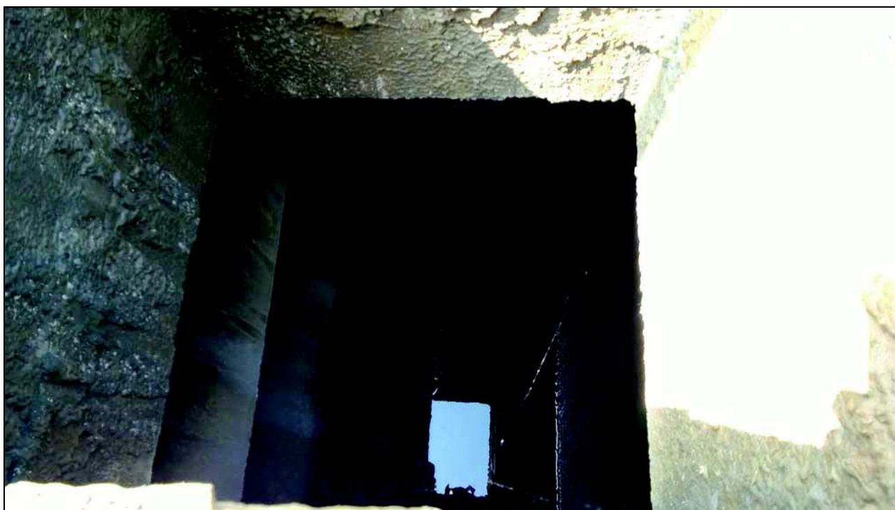
Foto 25 – Tombino di drenaggio posto al di sotto della strada interna di accesso all'area: vista interna dal chiusino 6.
