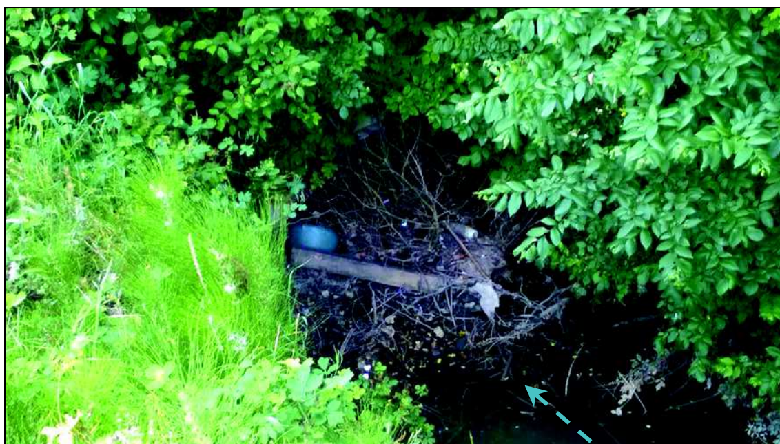
Fig. 9 – Particolare dell'ingresso del tombino posto 50m a valle della confluenza di fig.7: il deposito di materiale ha ostruito l'imbocco della condotta.
