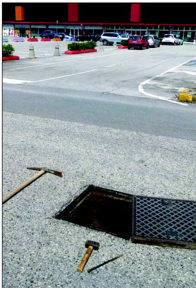
Foto 21, 22 – Strada interna di accesso all'area commerciale: posizionamento dei chiusini di ispezione sul tombino di drenaggio di un precedente canale di scolo
