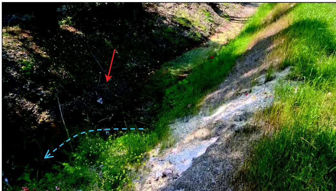
Fig. 7a – Punto di immissione del tombino attraversante l'area commerciale sul canale a margine della S.S. Romea: con la freccia rossa sono indicati i materiali trasportati dall'acqua e depositati di fronte allo scarico
