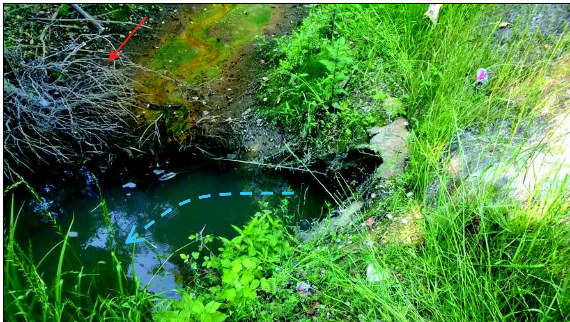
Fig. 8b – Particolare dello scarico del tombino attraversante l'area commerciale: deposito di materiali derivanti dalla pulizia del verde ripresi a Maggio e Giugno 2015
