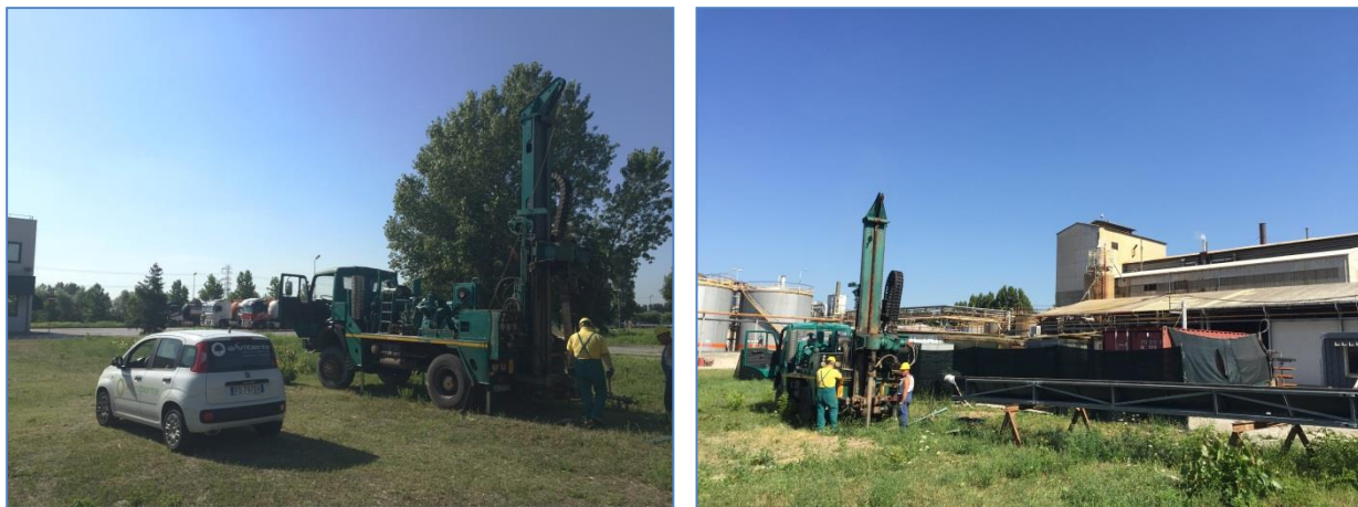
Figura 5.1. Indagini Eseguite - Realizzazione sondaggi a carotaggio
