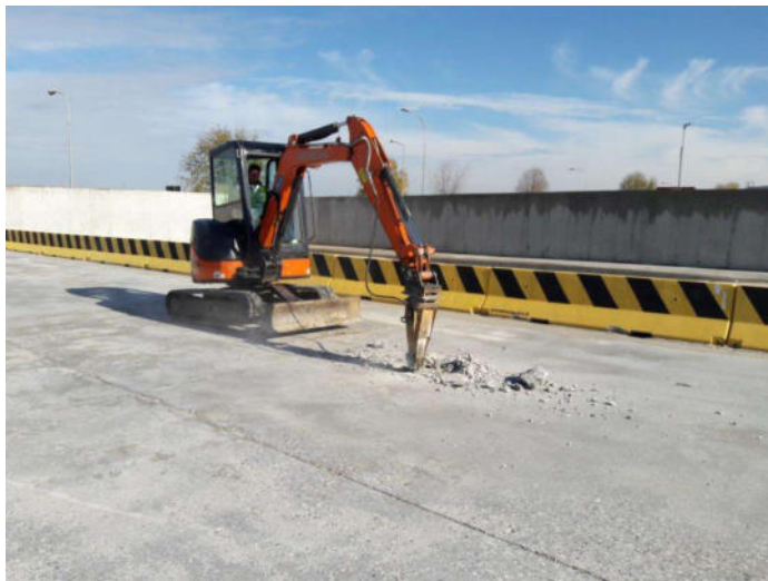
Esecuzione di prelievi integrativi previo demolizione solette
