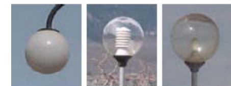
Impianto che disperde oltre il 60% della luce verso l'alto. I corpi illuminanti a sfera sono gli strumenti d'illuminazione più inquinanti ed inefficienti
