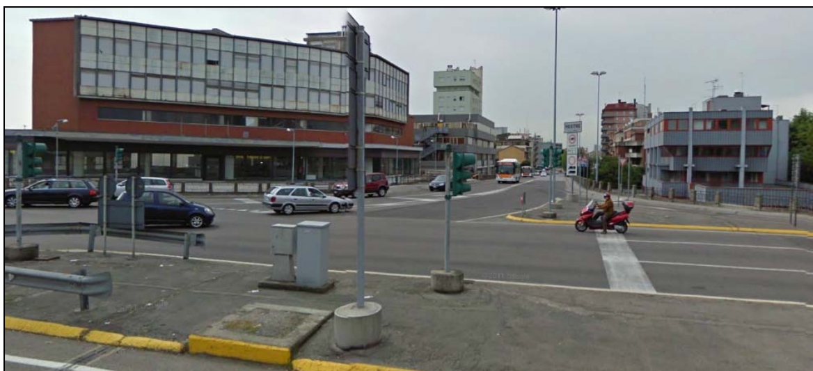
Figura 14 – intersezione Corso del Popolo, via Rampa Cavalcavia
