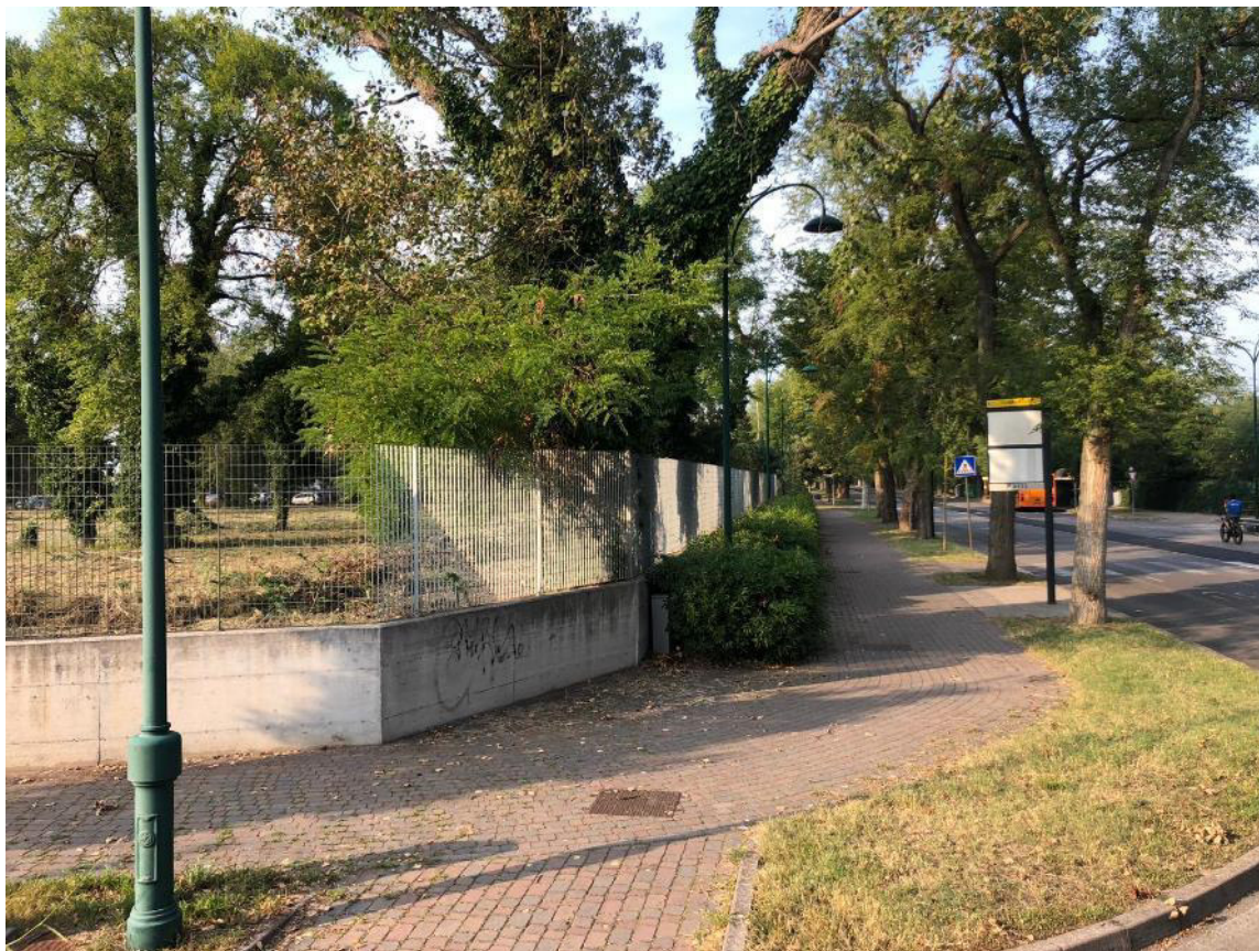
Foto 2 – confine est lungo la viabilità principale del Lido (via Malamocco). La proprietà è delimitata da cordolo e recinzione metallica
