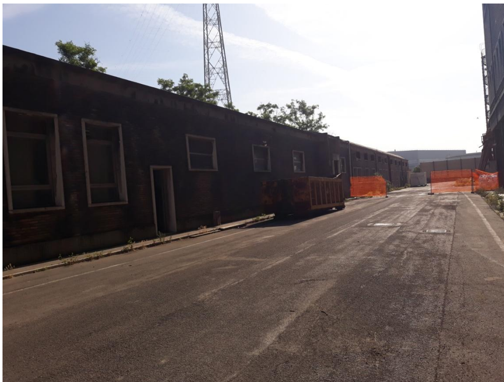
Figura 4: edifici sul lato nord oggetto di demolizione
