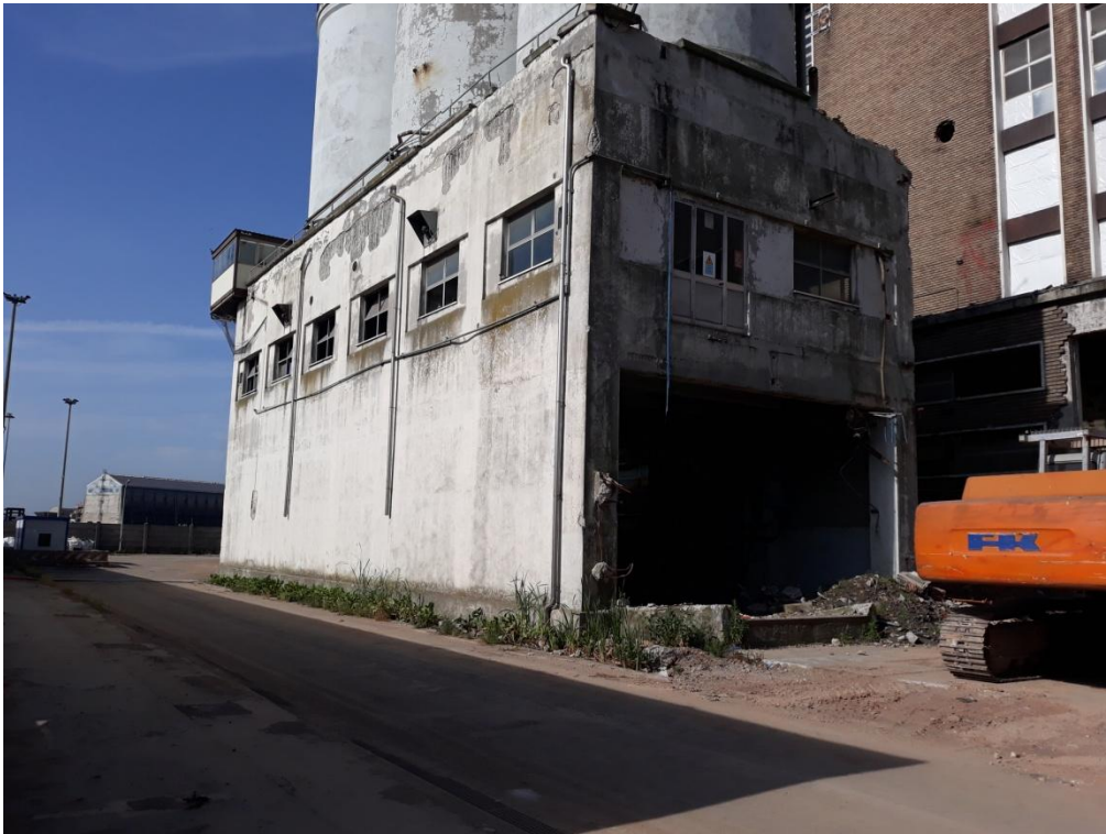
Figura 6: edifici lato Est oggetto di demolizione
