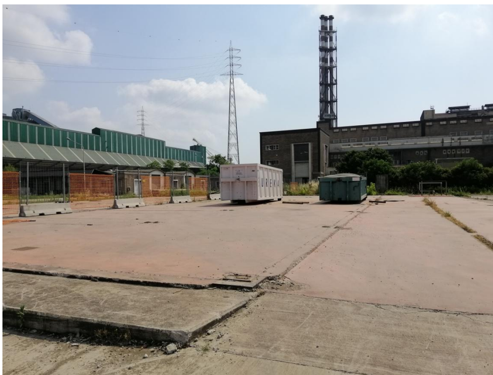
Figura 9: platea edificio già demolito, lato Nord
