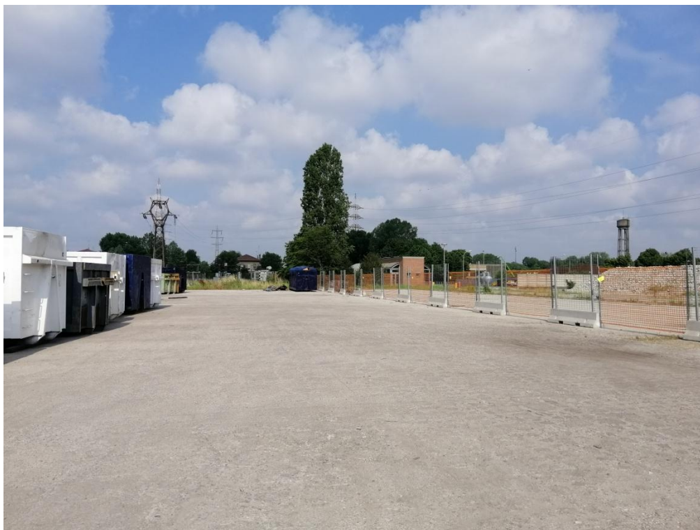
Figura 8: piazzale pavimentato lato Nord
