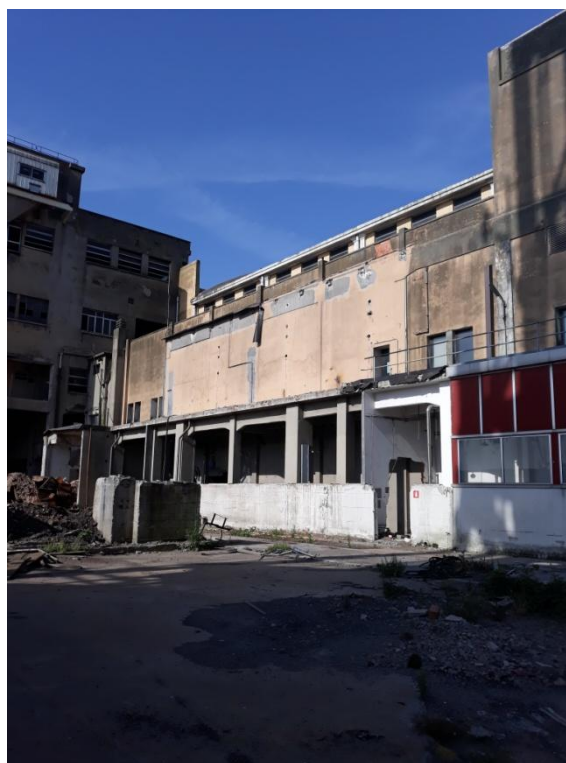
Figura 5: edifici lato Est
