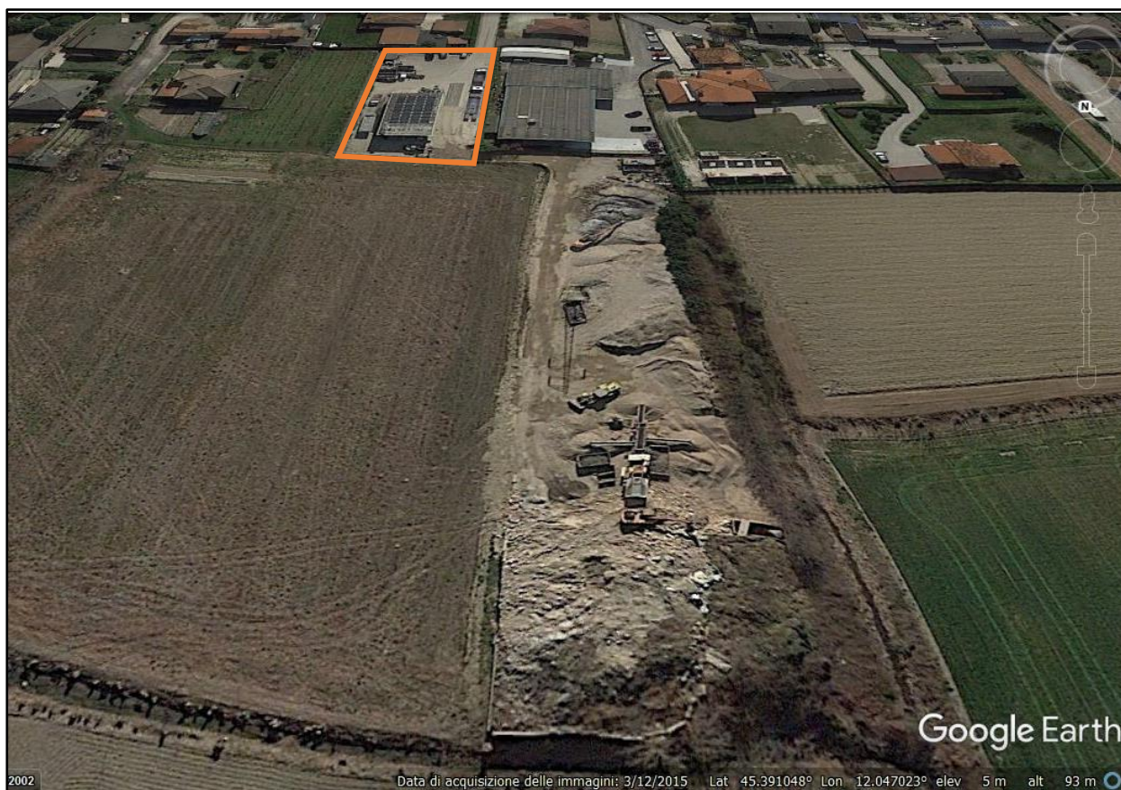
Figura 7: foto aerea dell'impianto di recupero di rifiuti inerti tratta da Google Earth. Evidenziata in arancione la sede aziendale.
