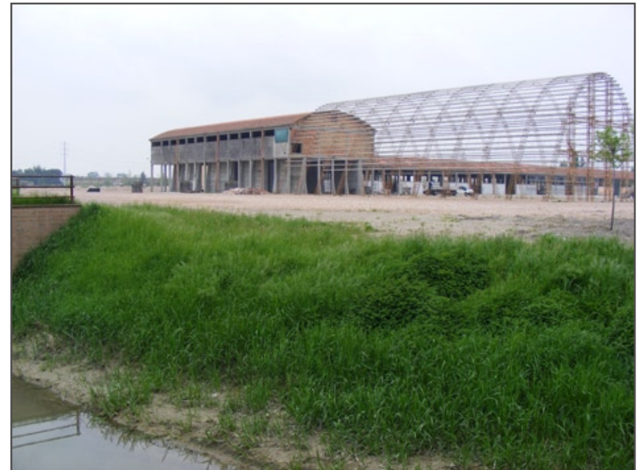
Edifici della ex fornace Cavasin - 2009
