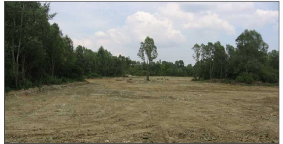
Prima fase dell'intervento - 2007
