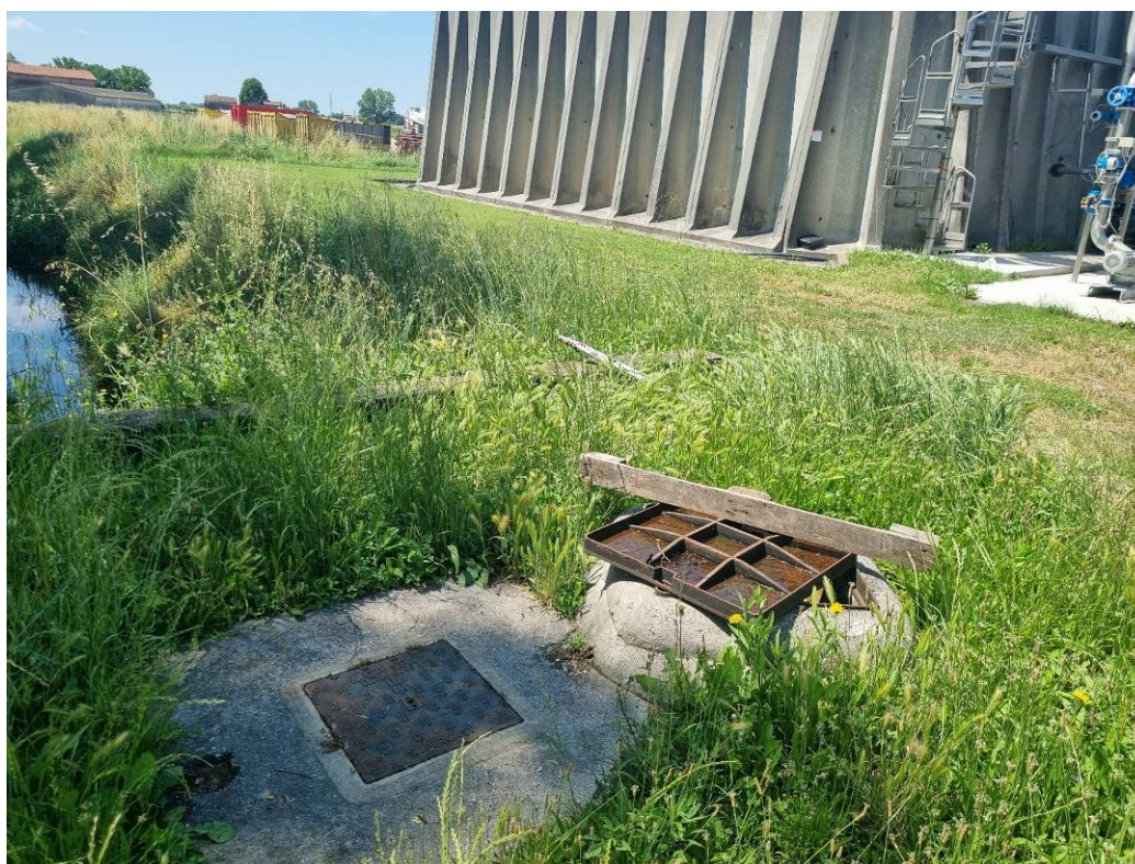
Foto 2: pozzetti fiscali per campionare le acque meteoriche dei piazzali e le acque depurate.
