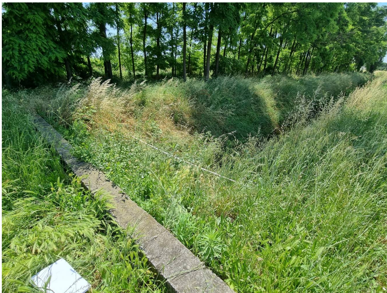
Foto 4: misurazione ciglio superiore 5 metri di larghezza, ciglio inferiore 1,5 metri di larghezza
