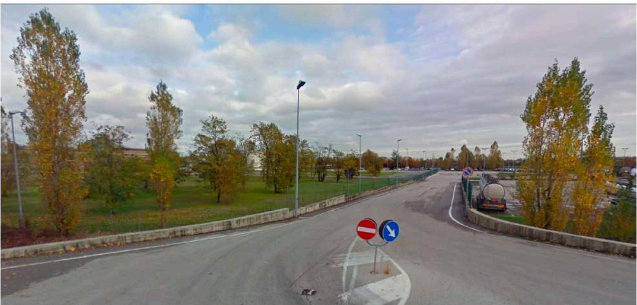
Figura 6. Accesso allo stabilimento (fonte Google Maps; SIA 2016)
