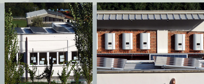
Particolari dell'impianto realizzato
