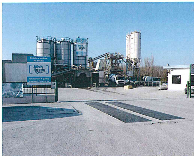
Vista impianti del calcestruzzo
