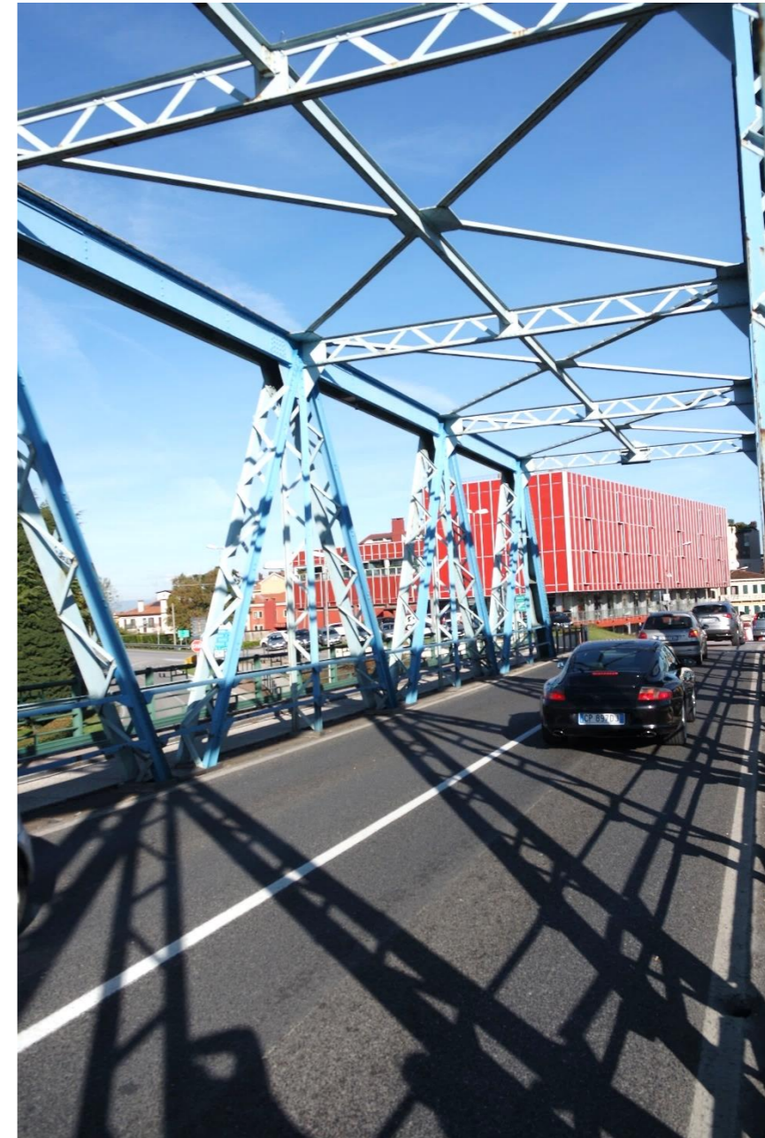
1 - L'edificio oggetto d'intervento visto dal Ponte della Vittoria all'ingresso della città
