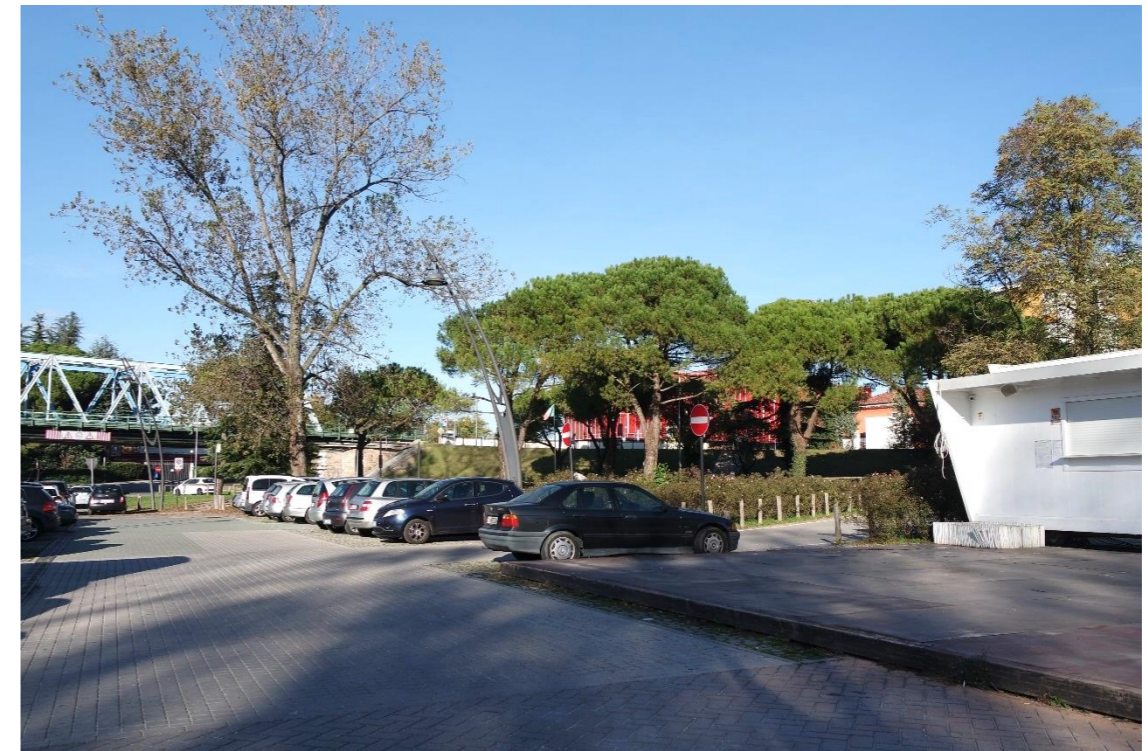
21 – L'edificio oggetto d'intervento dal parcheggio all'interno dell'area golenale a valle del Ponte della Vittoria
