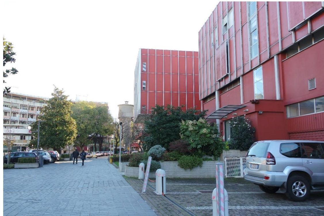
10 – Vista dall'angolo NO dell'area d'intervento verso Corso Silvio Trentin
