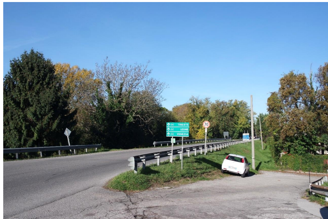
15 – Via Lungo Piave Superiore (Strada San Donà di Piave Romanzio SP 83) in direzione Romanzio
