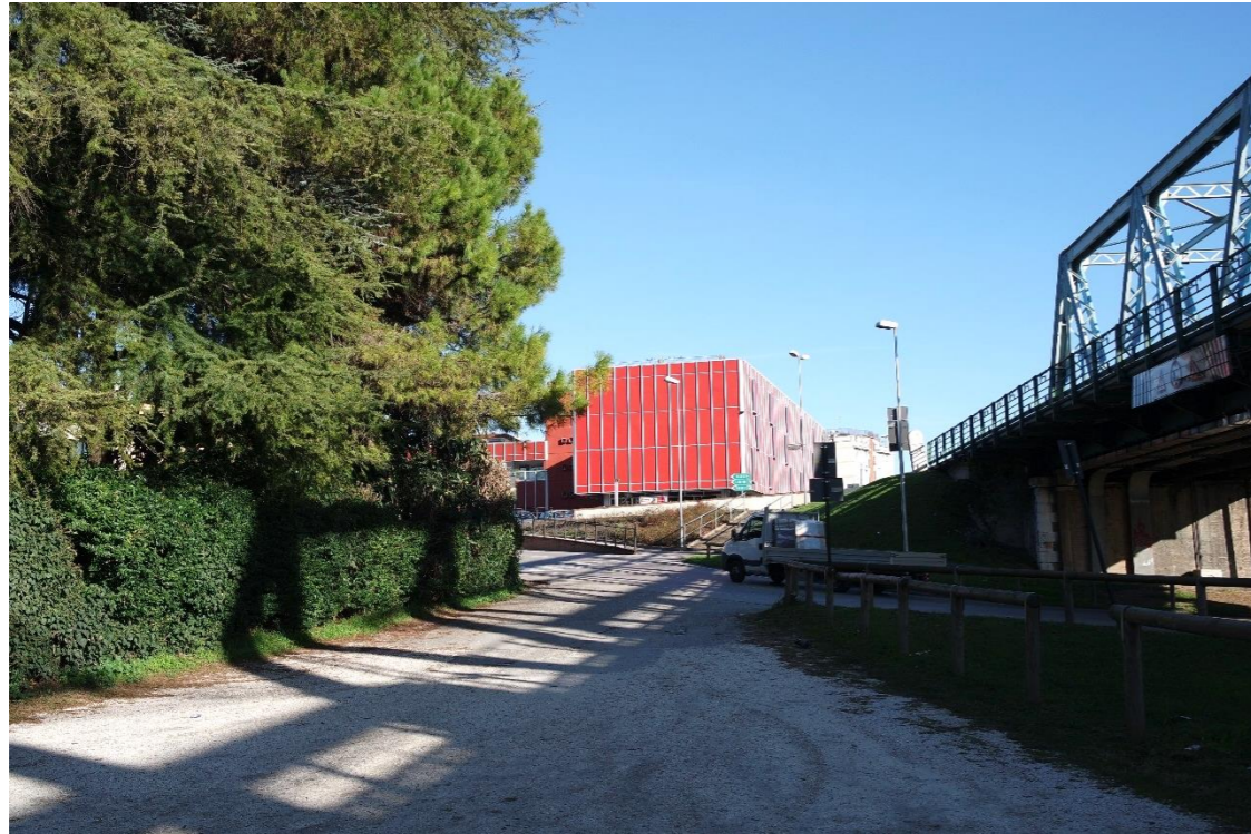
22 – L'edificio oggetto d'intervento visto dall'accesso alla pista ciclabile sulla riva del fiume a monte del Ponte della Vittoria
