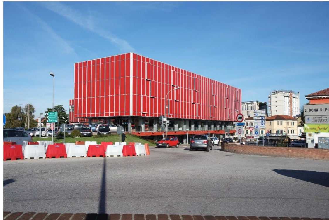
2 – Vista dell'edificio oggetto d'intervento dal marciapiede a lato del ponte
