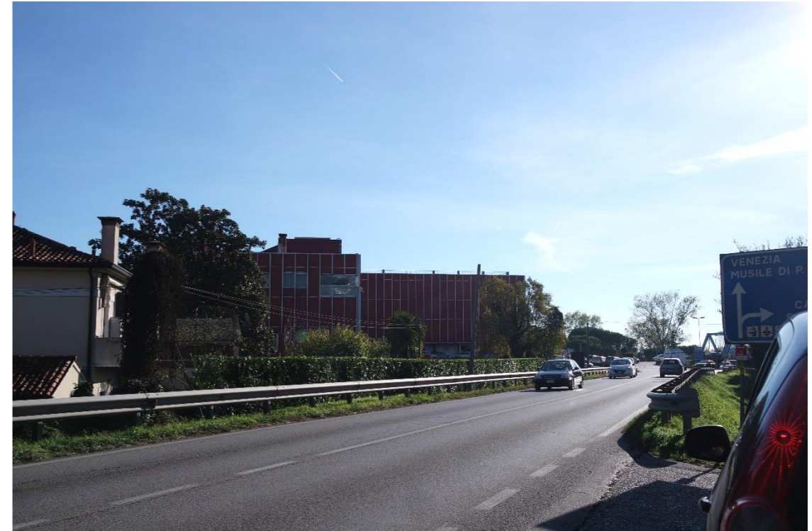
24 – L'edificio oggetto d'intervento da Via Lungo Piave Superiore
