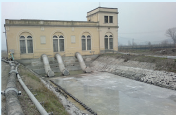
Fig. 16.20 - Lavori di modifiche dell'idrovora Ca' Bianca di Galzignano (PD) per adeguarla all'abbassamento del suolo causato dalle torbe.
