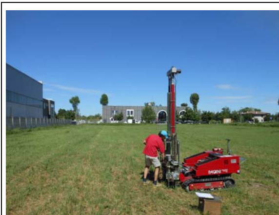
FOTO 1: PUNTO DI ESECUZIONE CPT 1
