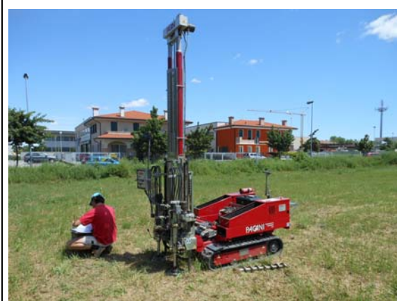
FOTO 3: PUNTO DI ESECUZIONE CPT 3
