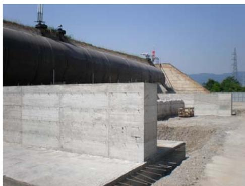
I serbatoi saranno provvisti di rivestimento protettivo avente particolari requisiti di resistività elettrica, aderenza, plasticità, resistenza meccanica, non igroscopicità, impermeabilità ed inalterabilità rispetto agli agenti aggressivi del terreno. La qualità dei materiali di rivestimento e la loro posa sarà dichiarata dal costruttore sotto la responsabilità del legale rappresentante.
