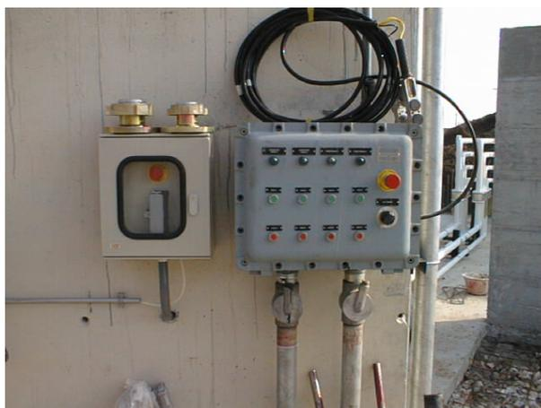
I bracci metallici e le manichette flessibili saranno conduttori per tutta la loro estensione. L'avvio dell'operazione di travaso sarà condizionata dall'assenso del collegamento di terra.
