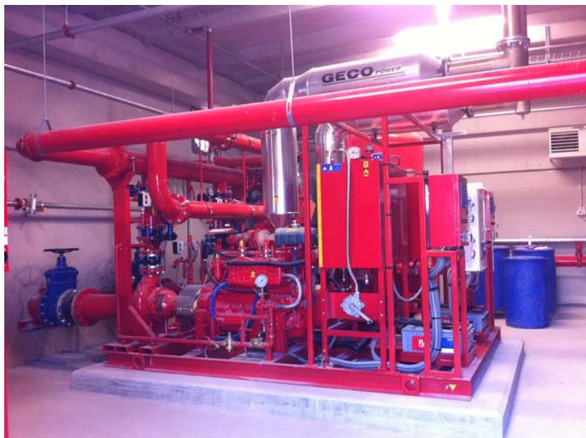
La postazione delle pompe antincendio è in posizione facilmente accessibile, distante oltre 20 metri dagli elementi pericolosi dell'impianto.
