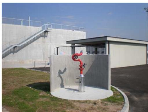
La rete di distribuzione sarà ad anello e divisibile in due tronchi mediante valvola di intercettazione, in modo da consentire la manutenzione senza interruzione del servizio. Le valvole saranno tali da visualizzare le condizioni di apertura e chiusura.
