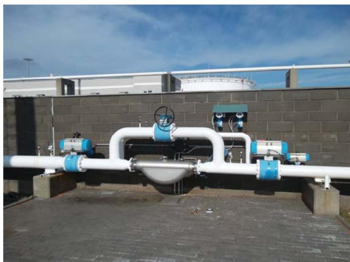
*Esempio di misuratore massico su linea carico serbatoi da banchina*
